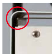
断熱二重構造のトンネル
