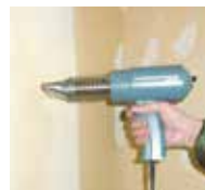
パテ材の乾燥 ノズル ヘラ型使用
